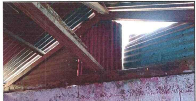
Foto 6: En esta fotografía se logra apreciar el mal estado del entechado y la necesidad de sustituirla por láminas troqueladas.
